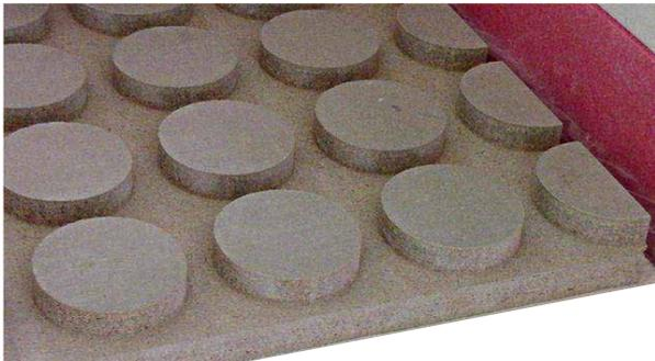
Lasciare circa 10 mm di spazio perimetrale tra la guarnizione morbida ed i pannelli radianti BetonRadiant nei perimetri delle stanze, come giunto di dilatazione.
