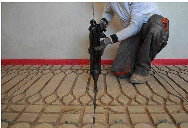
Contestualmente all'appoggio dei pannelli BetonRadiant sui piedini, stendere malta cementizia bicomponente ed impermeabilizzante Mapelastic (Mapei) sui bordi della battentatura.
