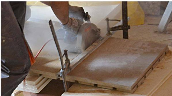
Utilizzare strumenti idonei per effettuare i tagli dei pannelli BetonRadiant suggeriamo seghe circolari, seghe da banco, gattucci, flessibili muniti di lame da legno al carburo o diamantate, e impianti di aspirazione idonei.
