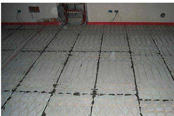
Una volta stuccate tutte le fughe fare essiccare il materiale di giunzione come indicato dal produttore, e pulire i canali con aspirazione.
