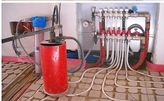
Poggiare le prime lastre di pannelli radianti a secco in cementolegno ad alta densità Beton Radiant partendo dal collettore principale, come nelle figure a fianco.
