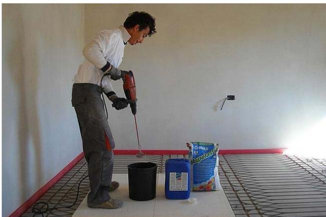
Posizionare e fissare i pannelli radianti, preparare il materiale per i giunti di dilatazione tra i pannelli (Mapelastic Mapei), fare un impasto abbastanza liquido per agevolarne l'estrusione.
