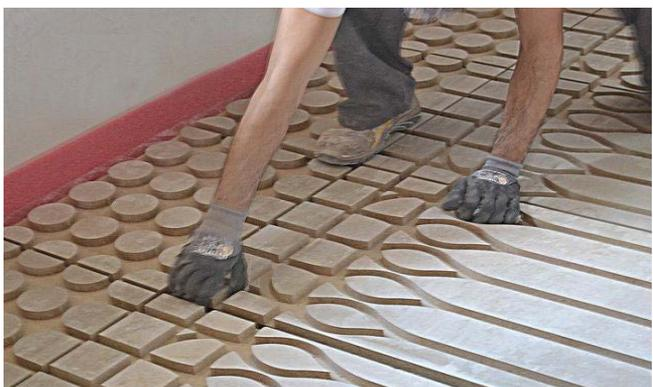
Continuare la posa dei pannelli Beton **Radiant** vicini, movimentarli se necessario fino a portarli in asse di stesura successive dei tubi, rispettando i distanziali, fissare i pannelli nei 5 punti stabiliti ai pannelli OSB o in legno sottostanti, con le viti della misura stabilita.
