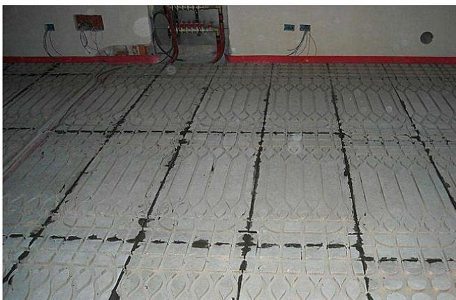
Una volta stuccate tutte le fughe fare essiccare il materiale di giunzione come indicato dal produttore, e pulire i canali con aspirazione. Verificare la planarità dei pannelli lignei sottostanti, ed il livello di bolla dei piani di futura pavimentazione.
