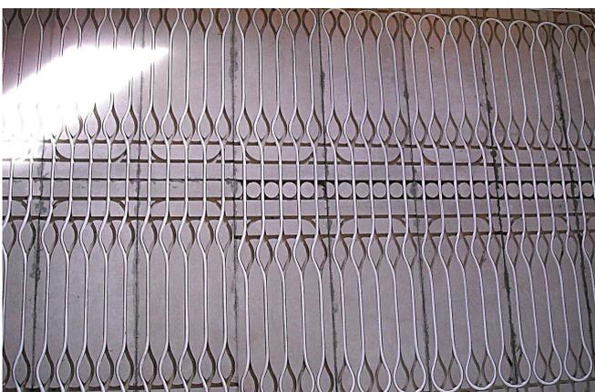
Posizionare i tubi seguendo lo schema di posa indicato dal termotecnico, partendo dai collettori e facendo i circuiti completi facendo attenzione a non danneggiare e ammaccare le tubazioni posate.
