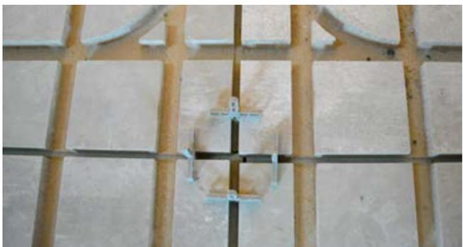
Per agevolare un'uniformità nella realizzazione delle fughe di dilatazione da prevedere nella parte sottostante dei pannelli Beton **Radiant**, si consiglia di usare delle crocette distanziatrici da ceramica.
