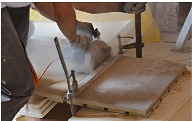
Utilizzare strumenti idonei per effettuare i tagli dei pannelli Beton **Radiant** suggeriamo seghe circolari, seghe da banco, gattucci, flessibili muniti di lame da legno al carburo o diamantate, e impianti di aspirazione idonei.
